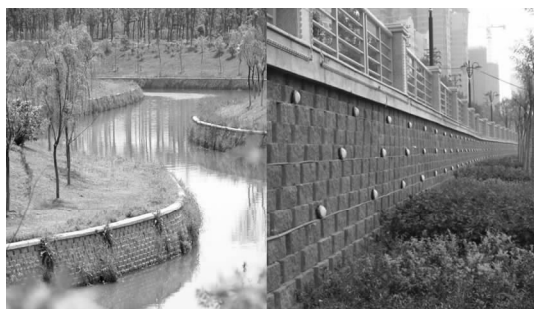
图2 自嵌式挡土墙工程实例
