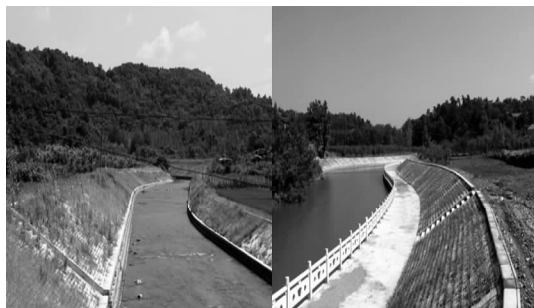
图3 生态连锁式工程实例
