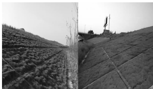
图1 生态型混凝土护坡工程实例
