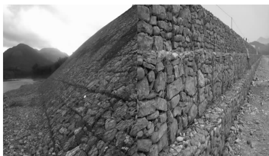
图4 生态格网工程实例
