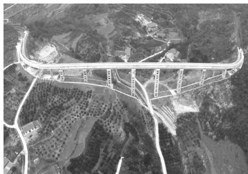
图2 蜘蛛洞渡槽竣工
