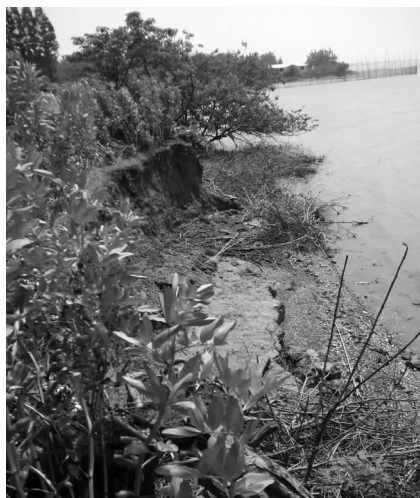
图1 东港湖崩岸实况
