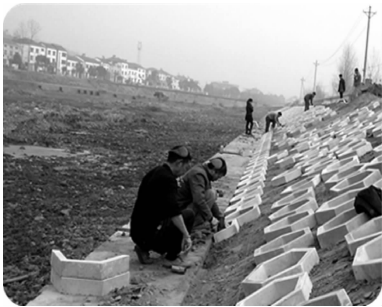
图3 混凝土框格安装
