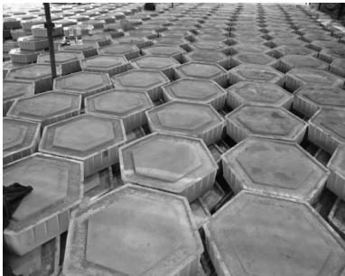
图2 混凝土框格制作
