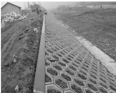
图4 生态混凝土浇注
