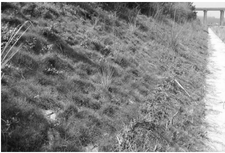
图 6 龙泉河生态混凝土护坡
