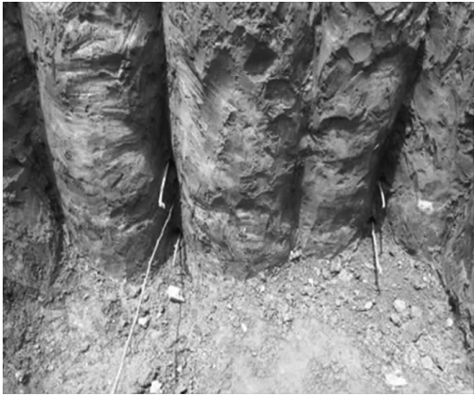
(a) (b) 图 2 防渗墙蚁道分布示意图(a)和蚁道现场实景(b)
