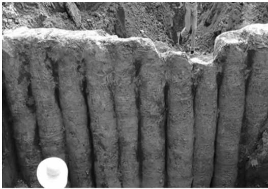
图4 标准(a)与不达标(b)深层搅拌桩防渗墙对比
