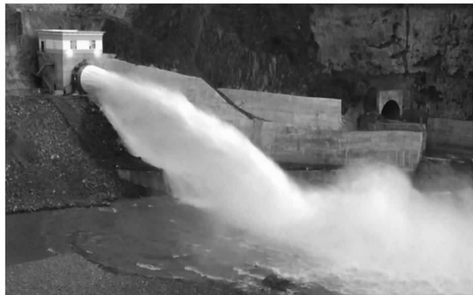
图 2 龙背湾水电站放空阀运行实景
